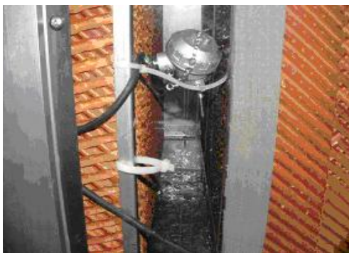
圖 6 出水口與蜂巢板安裝配合圖
